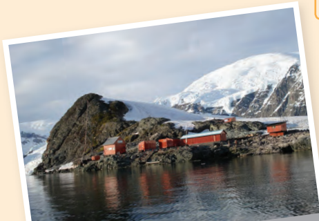
La base Almirante Guillermo Brown en el sector antártico argentino.
